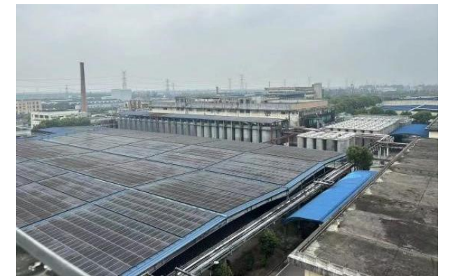
石库门工厂光伏照片
